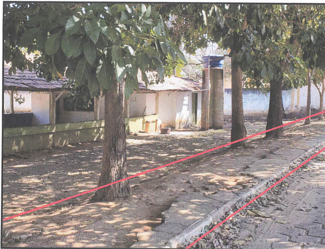
Imagem 07 – Local de assentamento do Passeio em Piso Intertravado
